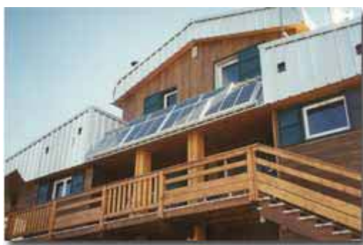
Un exemple d'utilisation de cellules photovoltaïques : le refuge de Bésines (Hautes Pyrénées)
